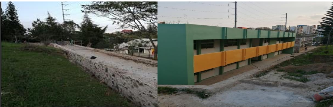
Ilustración 110. Construcción de edificios departamentales U2C.
